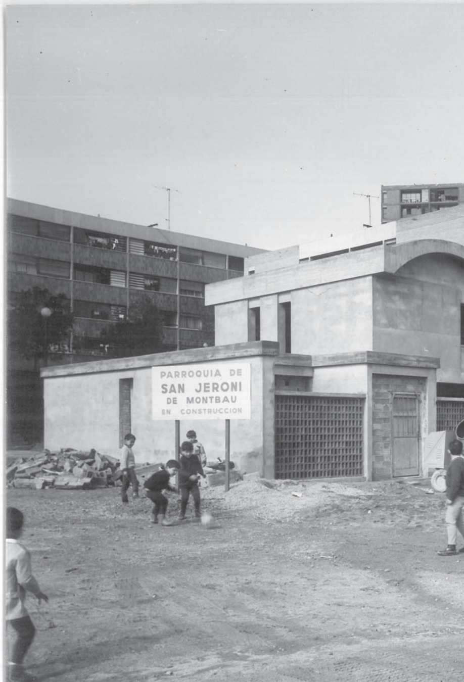
L'arquitecte Vayreda va emprar un sistema constructiu autòcton en la obra. Fotografia: Brangulí, cap al 1967. Col·lecció Carmen Giménez.
