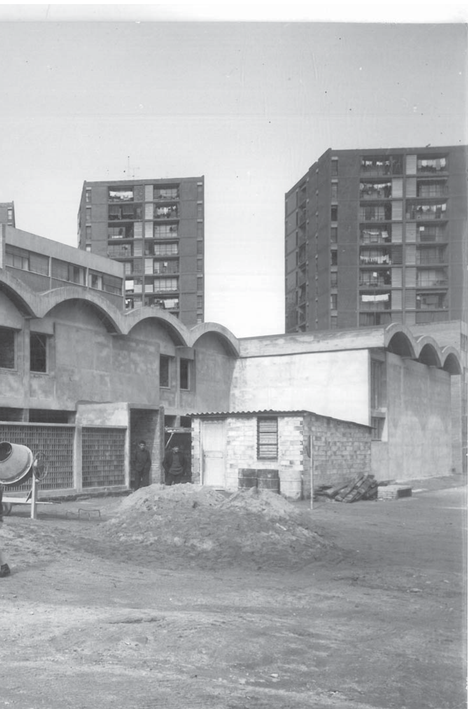
Construcció de l'església de Montbau: la volta catalana
