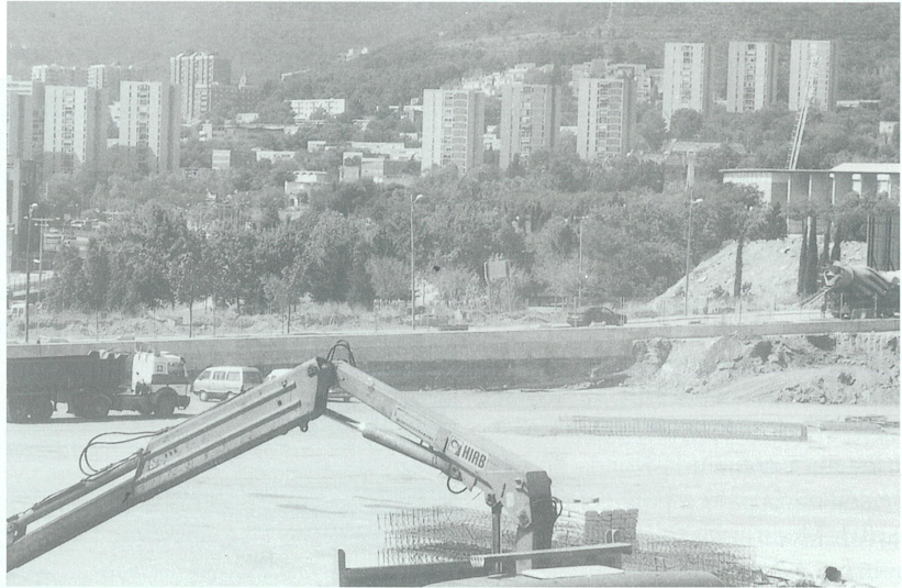
● Les excavadores, en plena activitat.
