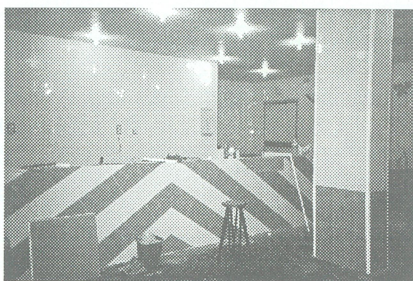
● El bar, durant les obres d'arranjament
