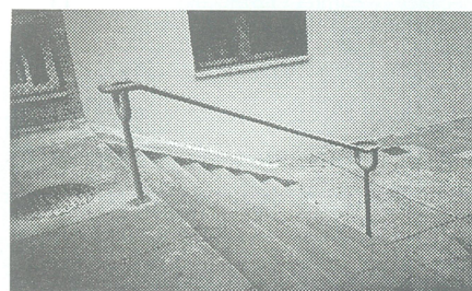
● Una de les baranes instal·lades a la segona fase
